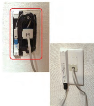
光アウトレットの施工例
