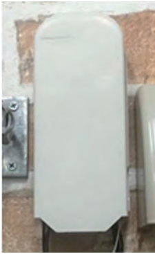
光キャビネットの寸法 横：77mm 縦：183mm 奥行：37mm
