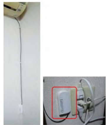
光ローゼットの施工例
